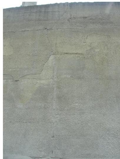
ფოტო 7-2: ბეტონის კედელზე ვერტიკალური ბზარი
