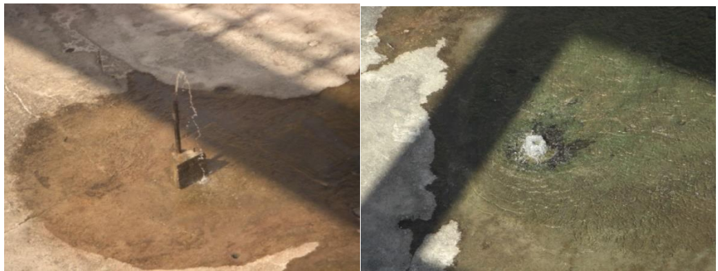
ფოტო 4-4: წყალსაგდების არხის ფსკერზე განლაგებული სადრენაჟო ბურღილებიდან წნევიანი წყლის გამოდინება
