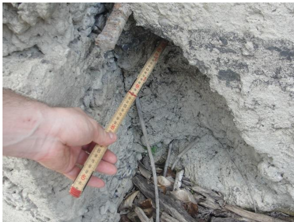
ფოტო 7-1: ბეტონის კედელზე არსებული >10სმ მკტი ეროზია
