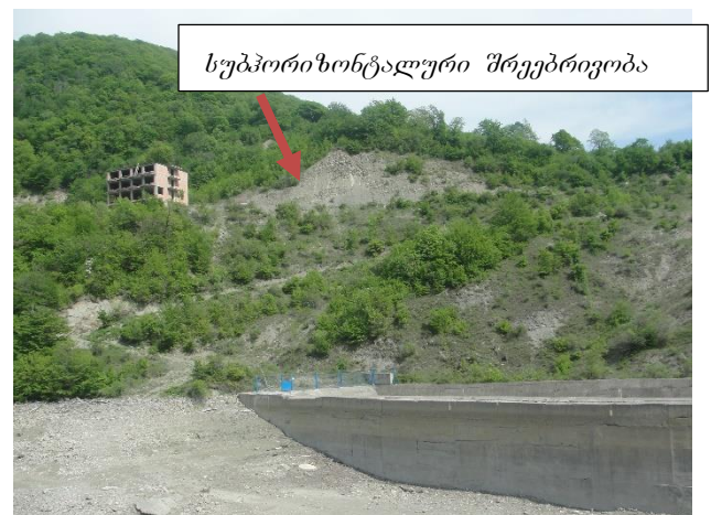
ფოტო 4-2: წყალსაგდების მარცხენა ფერდობზე არსებული სუბპორიზონტალური შრეებრივობის გაშიშვლება
